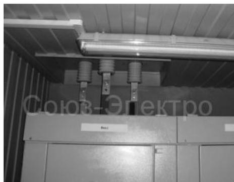
**Воздушный ввод 10 кВ в БМКТП через проходные керамические изоляторы типа ИПУ (защитный кожух снят)**
