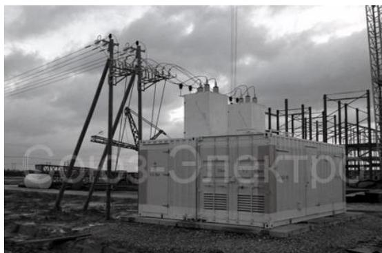
**БМКТП с установленными порталами воздушного ввода 15 кВ**
