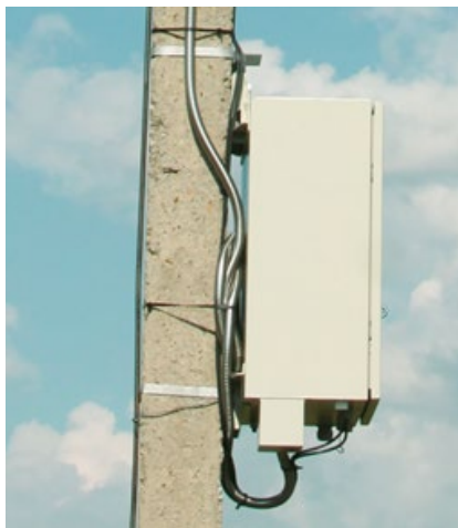
Рис. 4.29. Крепление бухты с соединительным устройством за шкафом управления
