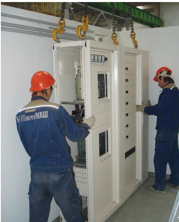
Установка НКУ в БКТПБ
