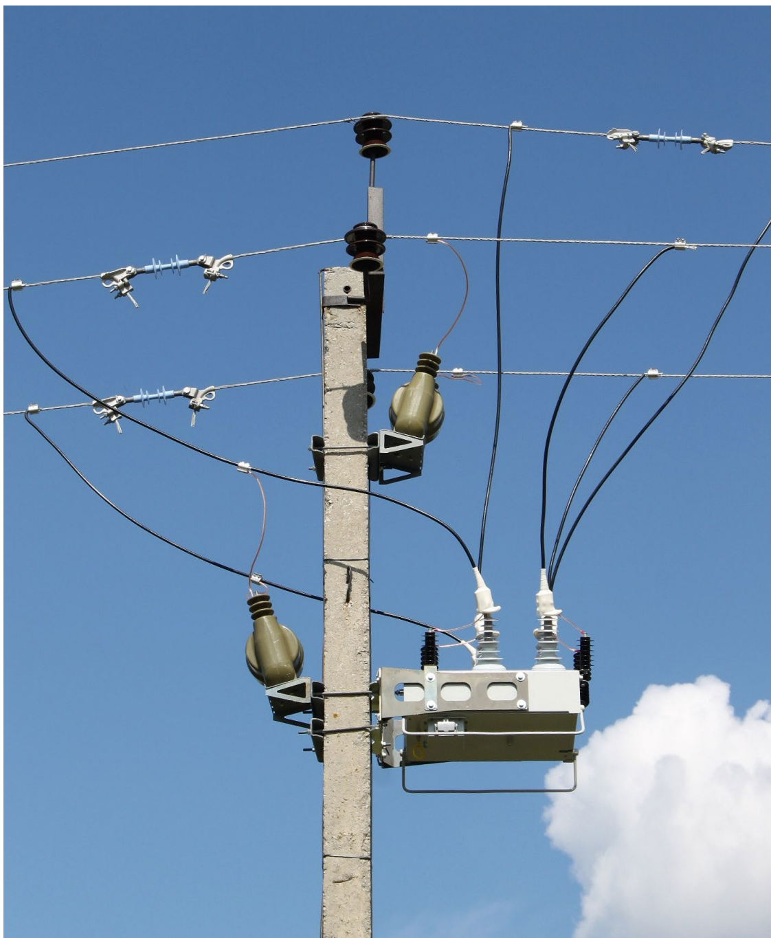
Рис. 1.1. Общий вид реклоузера TER_Rec15_A11_L5
